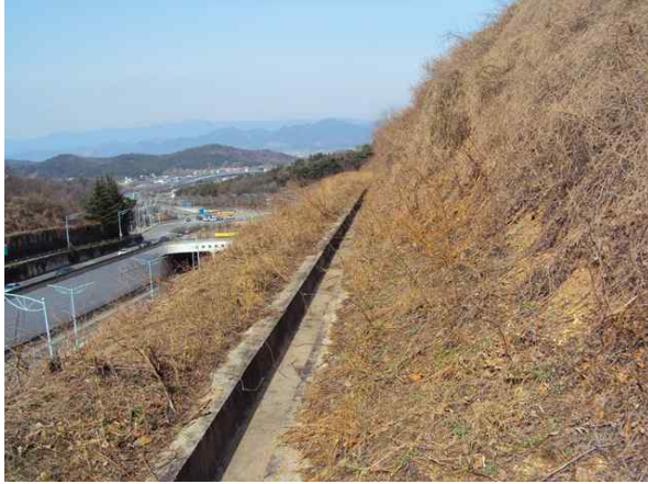
1소단 배수로 전경
