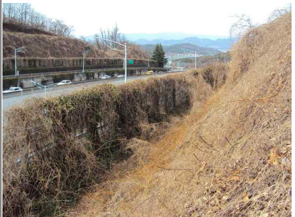
낙석방지울타리 및 하부 전경
