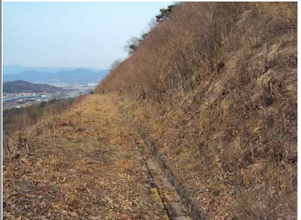
4소단 배수로 전경
