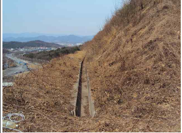
2소단 배수로 전경
