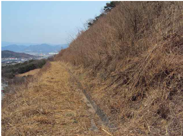
3소단 배수로 전경
